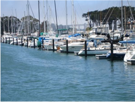
Marina Guide Piles
