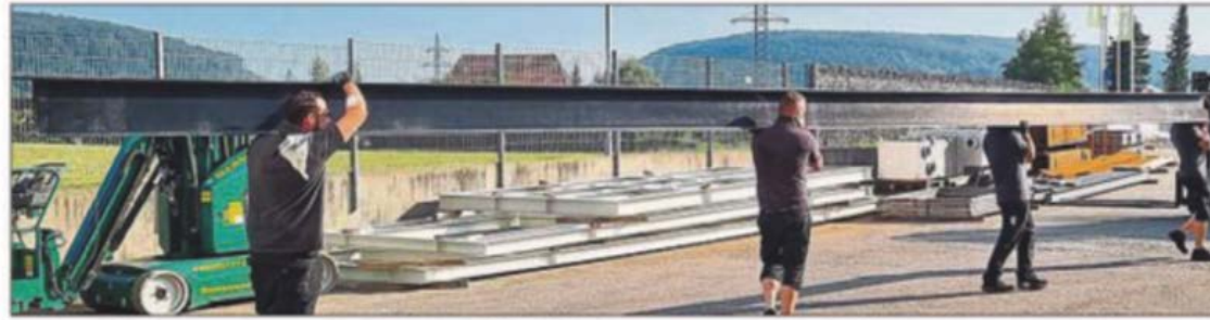
tragen ein Profil aus dem Faserverbundstoff. Der 13 Meter lange Träger wiegt 150 Kilogramm. »Aus Stahl würde er 1,25 Tonnen wiegen«, sagt [REDACTED]
